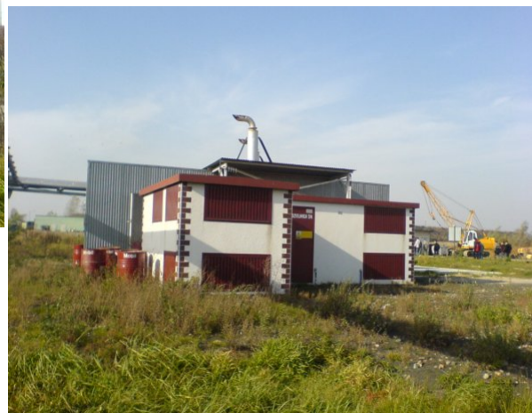
Budynki stacji transformatorowych i rozdzielni
