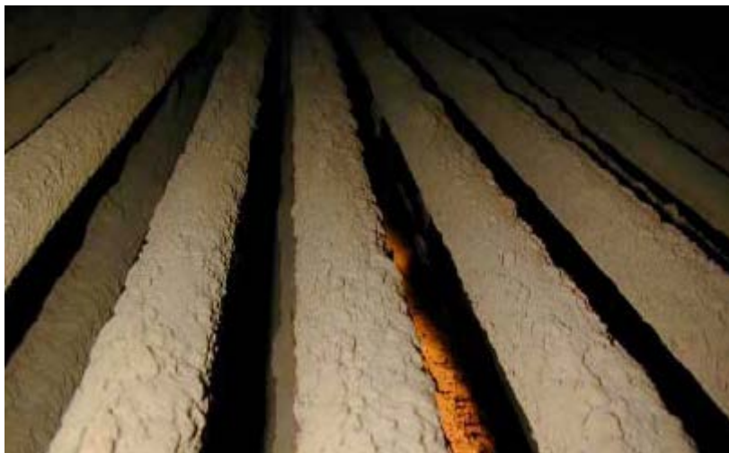
Rys.8. Proces szlakowania kotła zasilanego biomasą, źródło:
