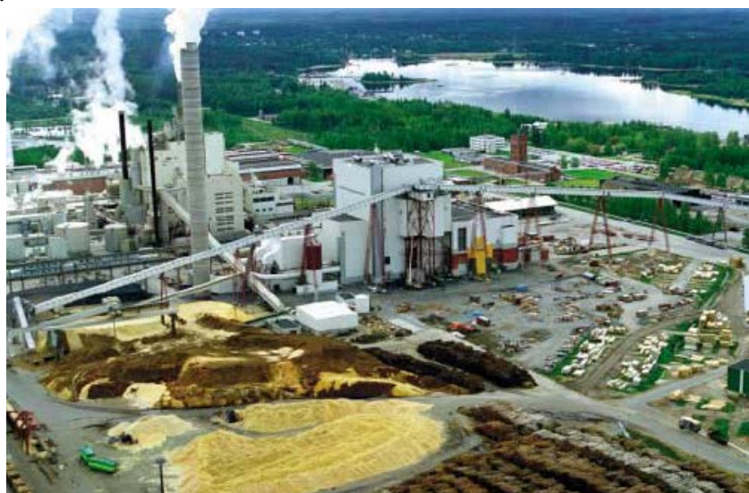
Rys.1. Elektrociepłownia Alholmens (Finlandia), w której realizowany jest proces współspalania biomasy
