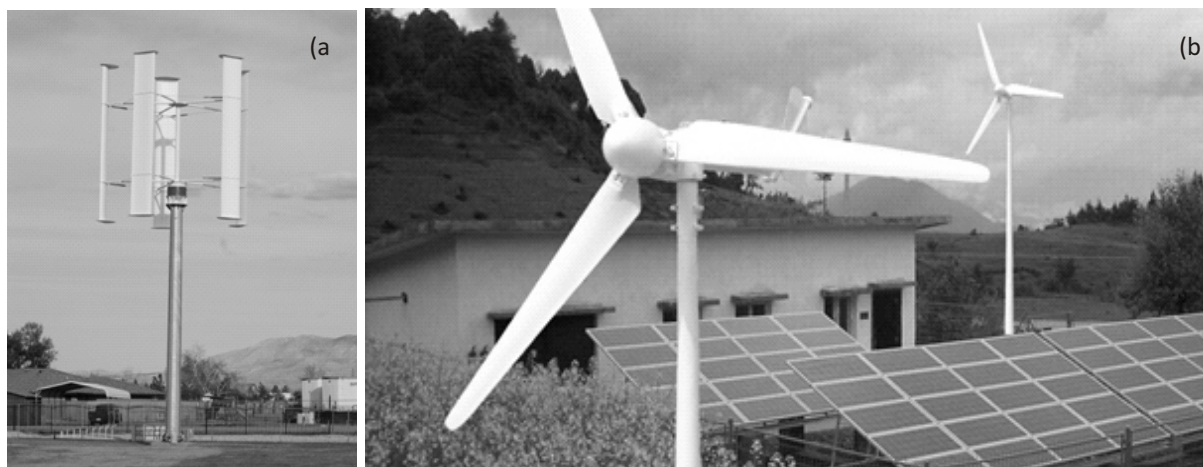
Fotografia 2. Małe turbiny wiatrowe: a) VAWT (WePOWER, LLC), b) HAWT (ZIBO CAT WIND GENERATOR CO., LTD).
