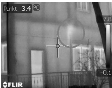
Rysunek 4. Nieszczelność powodująca ucieczkę ciepłego powietrza wewnętrznego widoczna od strony zewnętrznej.
