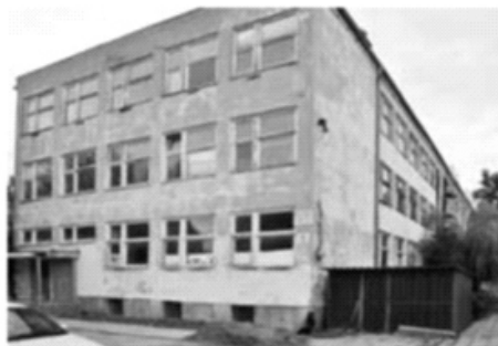
Obiekty poddane termomodernizacji, przed realizacją. Fot. M. Strama
