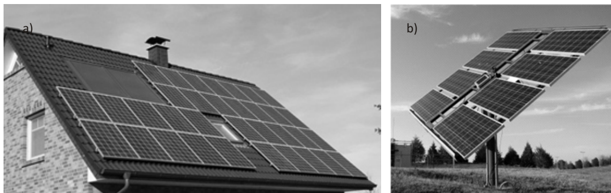
Fotografia 1. Przykład montażu paneli fotowoltaicznych: a) bezpośrednio do konstrukcji budynku (SolarSom), b) wykorzystując system nadążny (Brasit).
