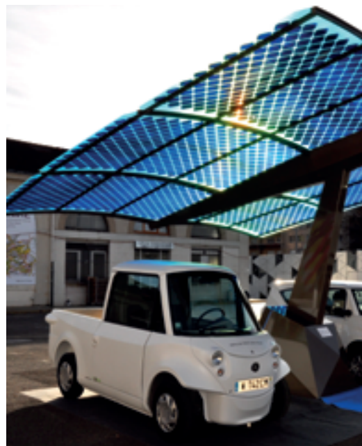
Rysunek 22. Mała architektura fotowoltaiczna i samochód elektryczny.
