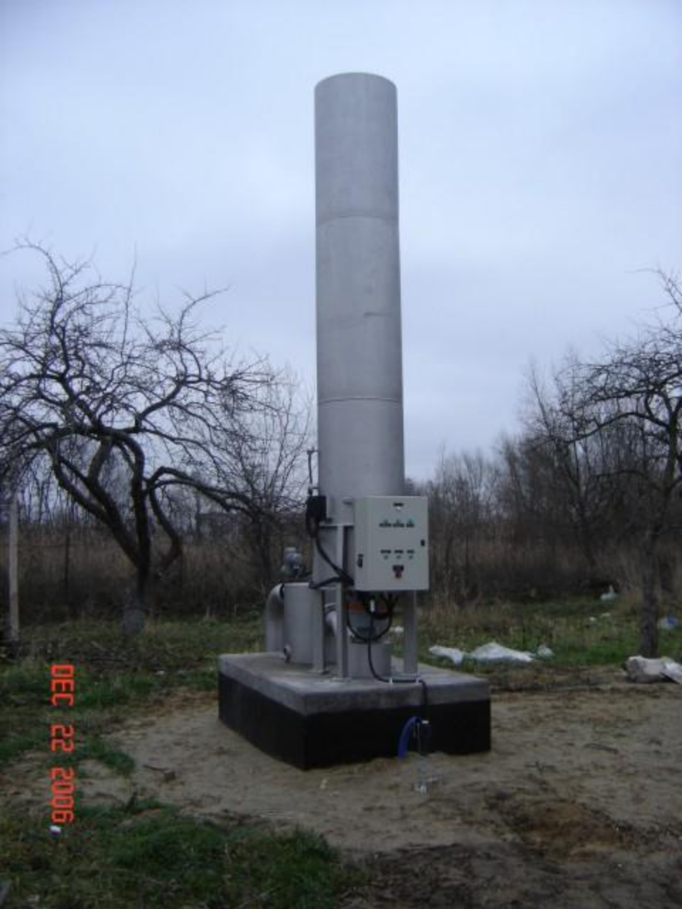
Pochodnia do spalania biogazu ZwiK Szczecin
