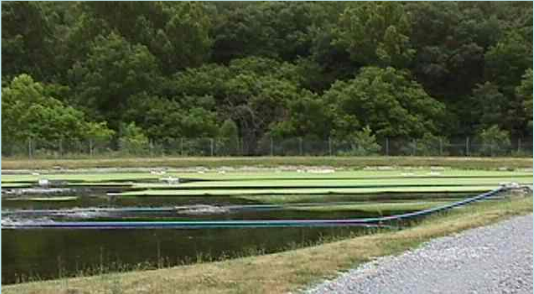
Napowietrzany staw biologiczny (Aerated Treatment Pond)
