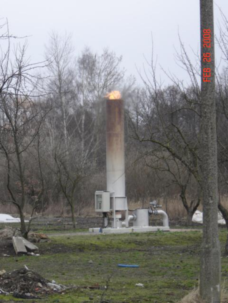
Pochodnia do spalania biogazu ZwiK Szczecin
