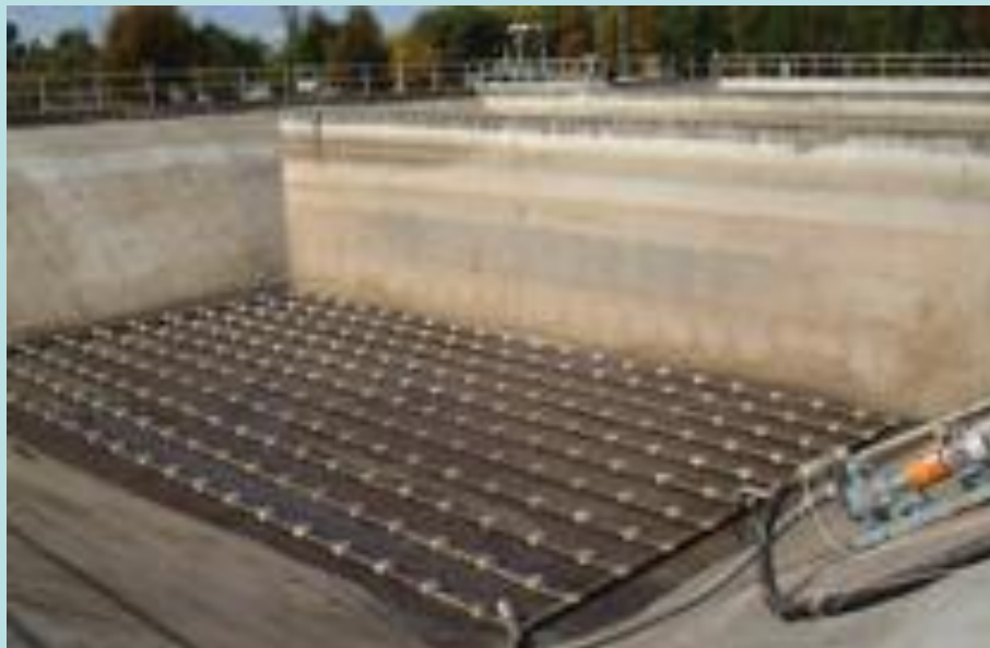
Różne systemy napowietrzania
