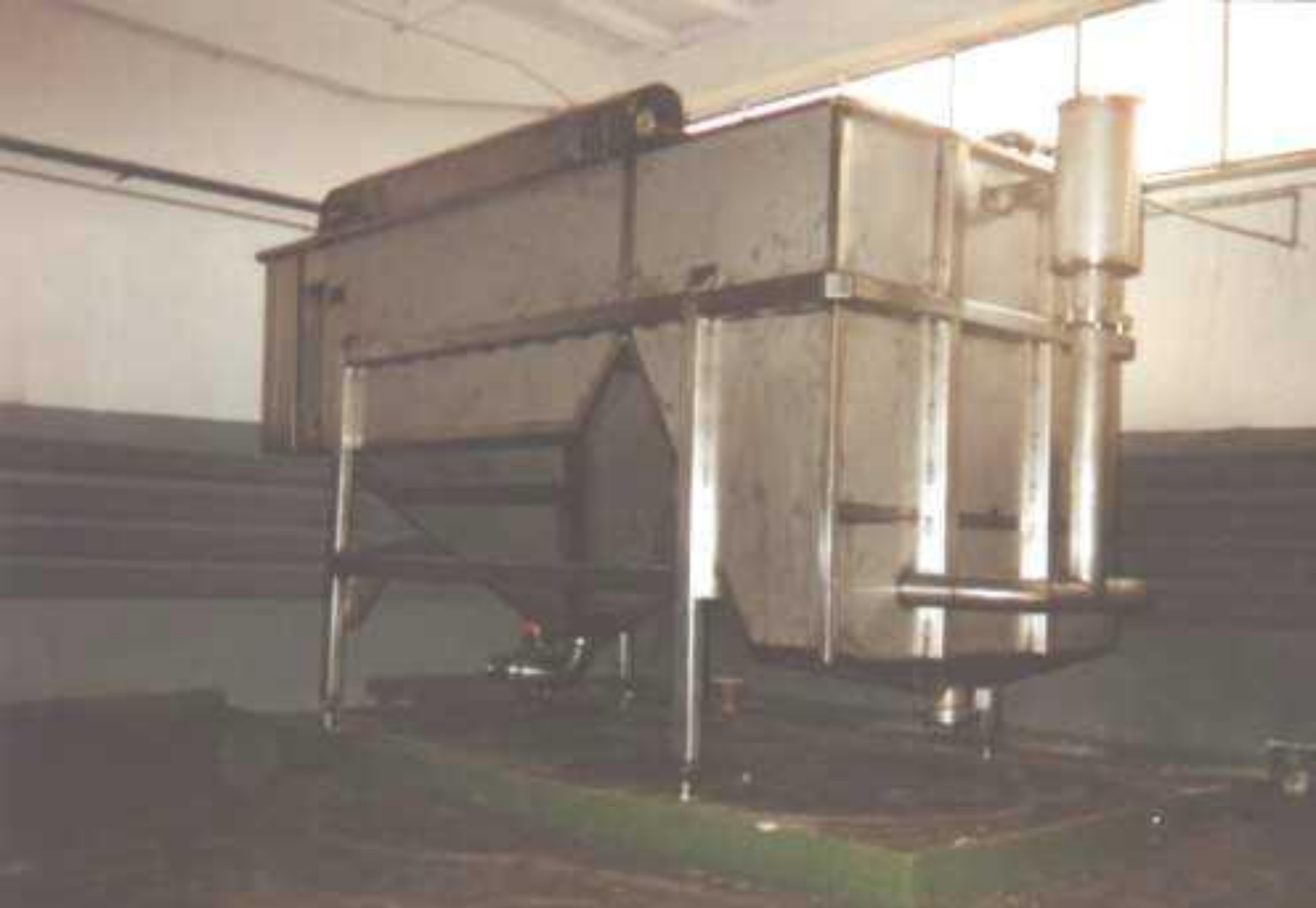
Odtłuszczacz firmy Ekobudex
