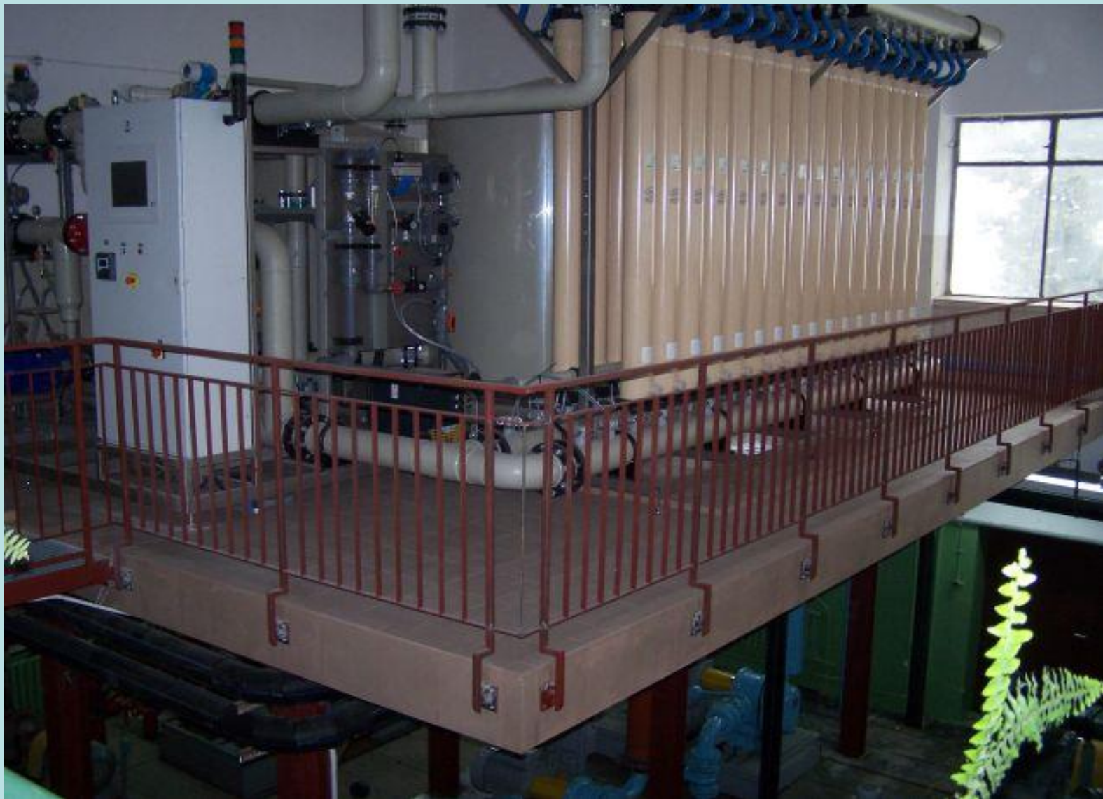
Układ filtrów membranowych firmy PALL 32 jednostki, wydajność 130 m 3 /h
