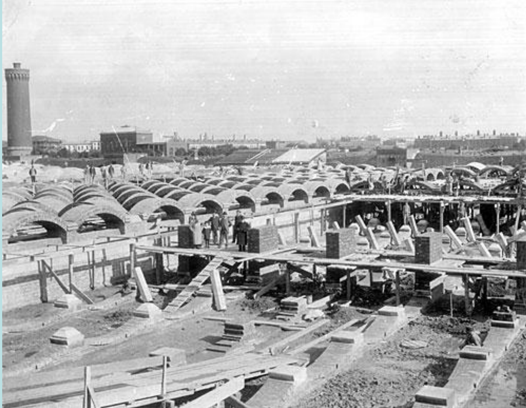
Budowa filtrów powolnych w Warszawie 1898-1900
