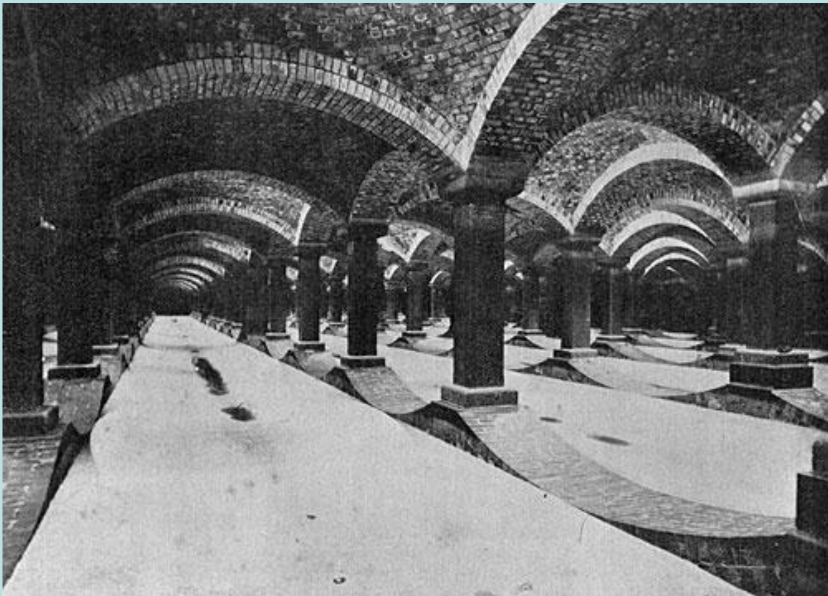
Wnętrze filtra, bez kanału zbierającego wodę i bez warstw filtracyjnych, wodociągi warszawskie.
