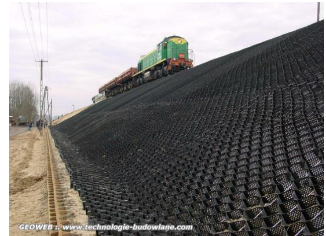
Wzmocnienie i stabilizacja zbocza nasypu kolejowego
