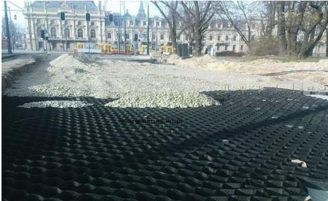
Zastosowania geokrata w modernizacji ulicy Północnej w Łodzi
