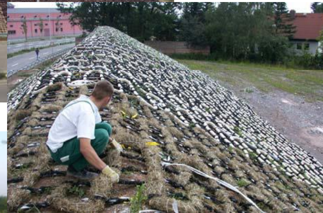
Instalacji geosiatki zbudowanej z siana.
