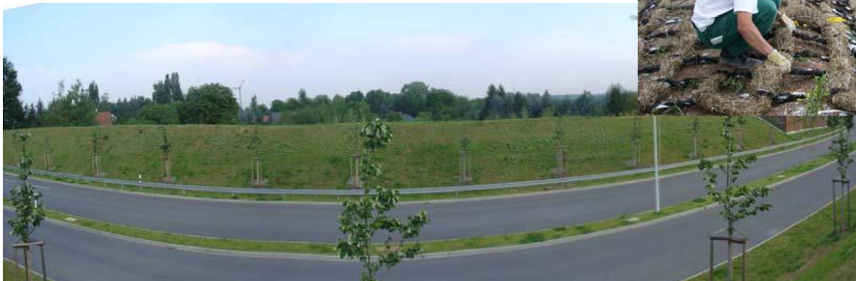
Nasyp po pięciu tygodniach po hydroobsiewie.
