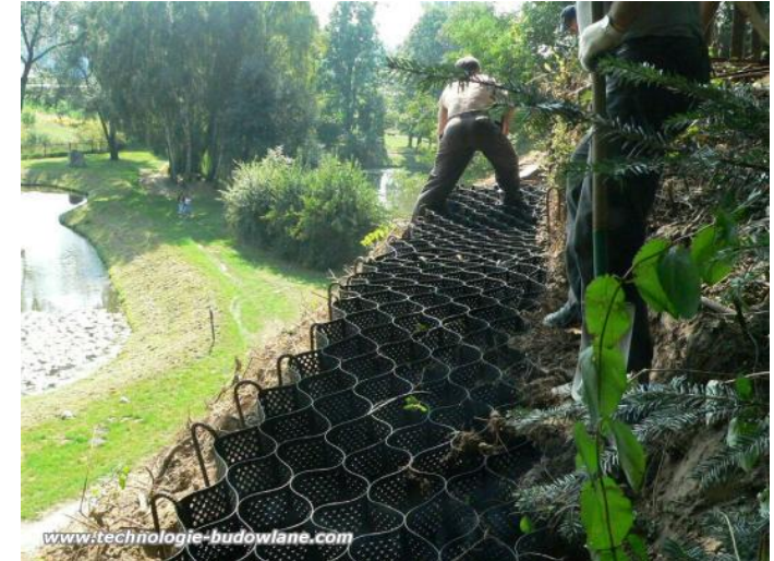
Wzmocnienie wałów przeciwpowodziowych
