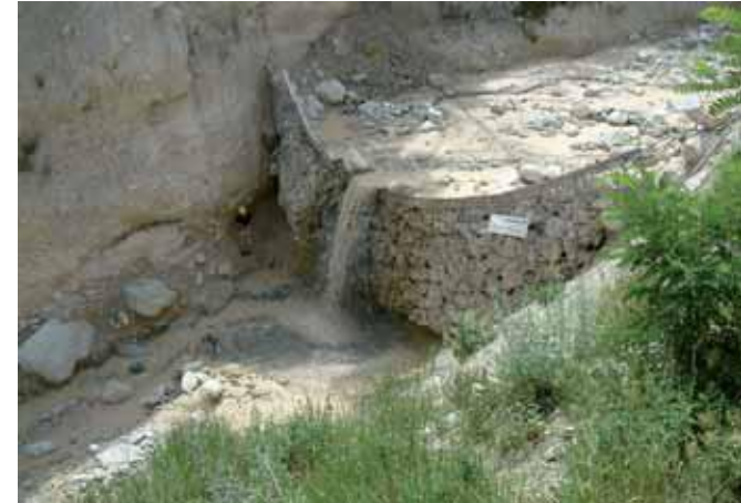
Bariera w Szwajcarii, po zatrzymaniu spływu gruzowego o objętości ponad 1000 m 3
